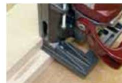
Reparatur im Falz
