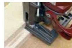
Reparatur im Falz
