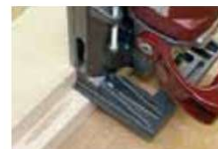
Reparatur im Falz
